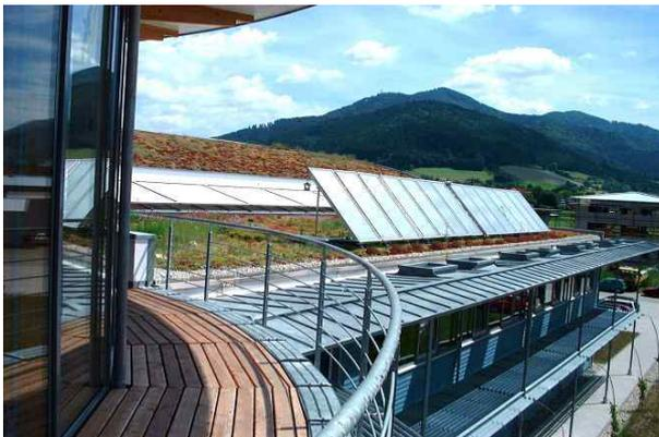
**Wasserkraft Volk AG, Zukunftsfabrik, Dach und Teilansicht.** Das Gebäude ist i.w. mit Holz aus der Region errichtet auf bauökologischer und Energiespar-Basis. Mit dem eigenen, gewässerökologisch nachgewiesenen vorbildlichen Wasserkraftwerk (Turbinen und Generatoren unten im Rundbau, Zuleitung aus Holzrohren) und intelligenter Energietechnik wird erheblicher Energieüberschuß erzielt. Die
