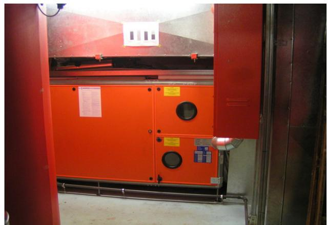
„Wohnen und Arbeiten“: im Technik-Keller Lüftungsanlage, Wärmerückgewinnung (nicht auf Foto: Klein-BHKW)
