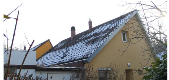
Im Bild 17, sind am Haus Britzinger 36 vor der Dachdämmung, auch noch deutliche Wärmelecks sichtbar.
