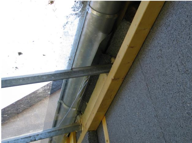
Ansicht oben. Darüber kommt noch eine 2,5 cm dicke Boden Deckel Schalung, links oben schon sichtbar.
