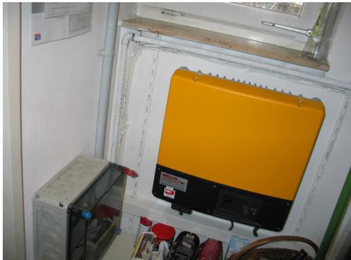
Der SMA Sonny Boy 4kW Wechselrichter kann leider keinen Inselbetrieb stützen und kann keinen Speicher laden.
