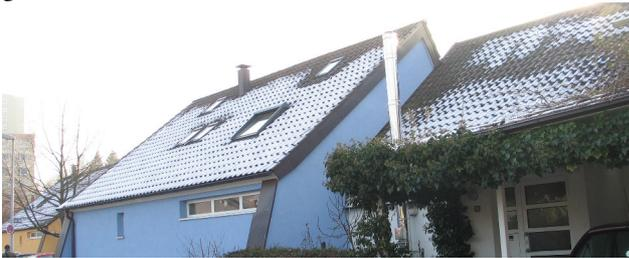
Die Wärmelecks lassen auf Ausführungsmängel schließen, beim Abkleben der Dampfbremssfolie.
