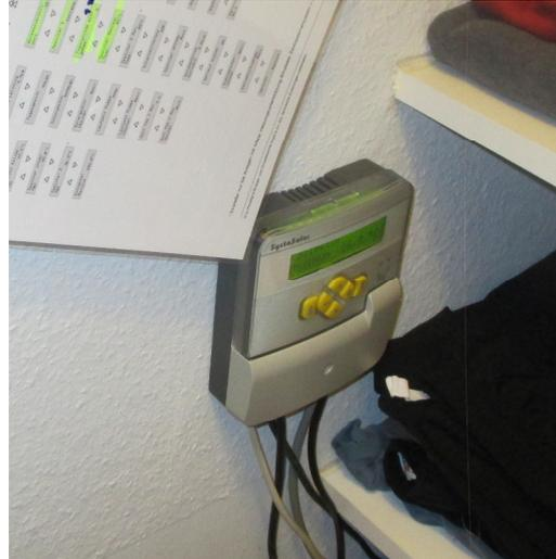
Die Eigenbau WW. Solarsteuerung wurde ersetzt und ist jetzt vom Kleideraum im Obergeschoss bedienbar. (Ehemals WC.) Zuvor war die Eigenbau Steuerung im Kriech Speicher Bild 5 bei der Wassertechnik untergebracht.
