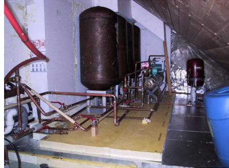
Zu Bild 5: Die Warmwassertanks bestehen aus 4 hintereinander geschalteten ehemals Kupfer Elektroboilern.
