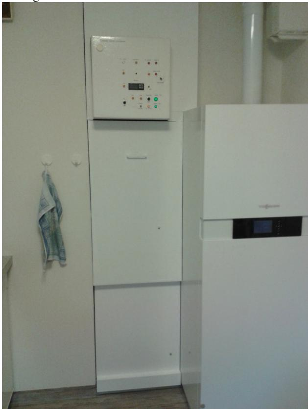
Zu Bild 8. Seit Oktober 2015 ist die Vitodens 222F, Viessmann Kombi Brennwert Therme mit 130l Warmwasserspeicher darunter installiert. Sie hat den alten Eigenbau Warmwasserspeicher und die alte Paradigma Brennwerttherme ersetzt.
