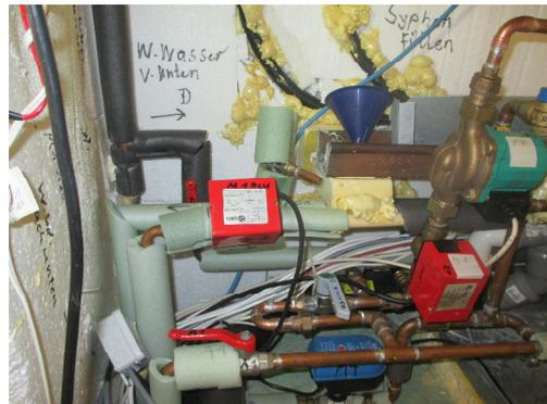
Hähne, Pumpe 7 und Motorventile. Das blaue M4 stellt den Kaltwasserzulauf ab, bei einem Leck. Dazu gibt es eine ausführliche Bedienanleitung.
