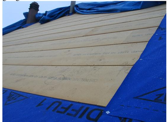
Hier fehlen nur noch die Konterlatten, Dachlatten und die Ziegel.
