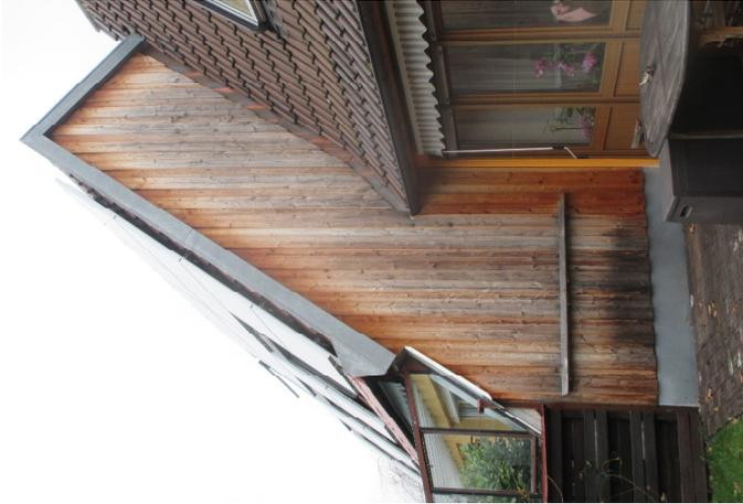
Der Ost-Giebel wurde 1983 mit nur 4 cm Styropor gedämmt. 2010 wurde eine 16 cm dicke Mineralwoll-Dämmung darüber montiert, die mit einer Boden-Deckel Holz- Schalung verkleidet wurde.
