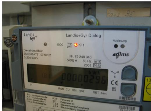
Der Zähler im Bild 3 erfasst den Netzbezug und die Rückspeisung.
