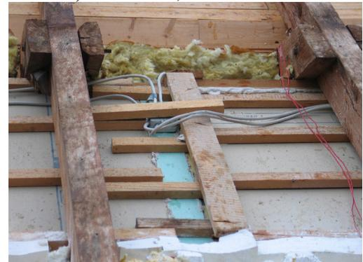
Die Gipsdielen sind schon oben gekürzt worden nach dem Entfernen der alten Dämmung. Sie stießen zuvor teilweise bis knapp unter die Ziegel.
