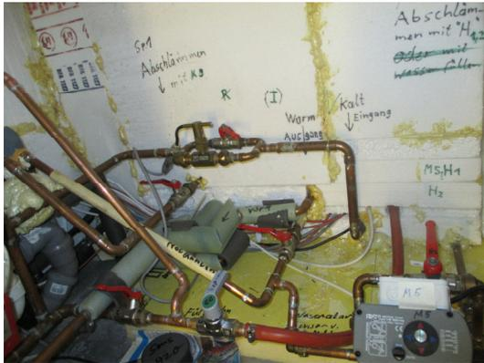
Die Styroporeinhausung trennt die heißen Speicher von den anderen Bedienelementen.
