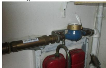
Das Aqua Bion System schützt vor Durchrostung und Verkalkung. Es besteht aus einer passiven Zinkopferanode, die nach ca. 10 Jahren ausgetauscht wird.
