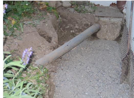
Im Regenwasser Abzweig Kasten ist ein Boden mit Überlauf und Ablauf in das waagerechte Rohr zum Tiefspeicher eingebaut. Erst wenn dieser voll ist läuft das Regenwasser in die Kanalisation ab.
