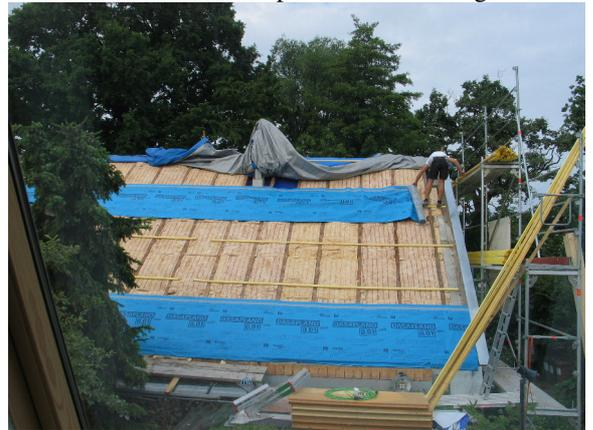
So eine Dämmung, bis Oberkante Sparren plus 8cm Gutex Weichfaserplatten oben drauf hat das Haus Britzingerstr. 36 ebenfalls 2010 mit der Dach Neudämmung bekommen.
