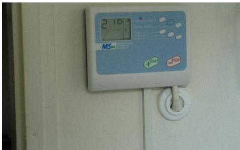
Die MS Steuerung im Bild 20 versorgt die Waschmaschine mit abwechselnd warmem und kaltem Wasser der richtigen Temperatur, je nach Wasch Programm. Das spart Strom ein, der nicht zum Aufheizen gebraucht wird.
