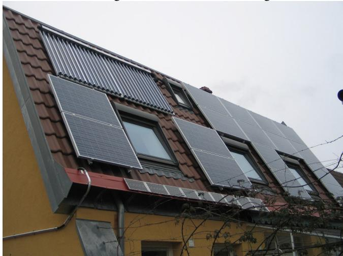
Bild 1 zeigt den Zustand von Dach nach 2013, nach der Installation der Fotovoltaik mit 3,5 kw peak.
