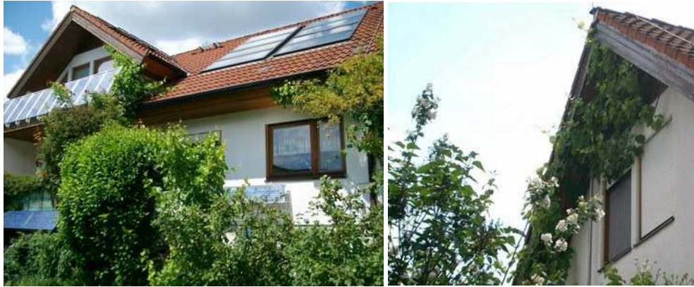
links: Verschattung durch Dachüberstand und Balkon. Rechts: Ostfenster teils durch Rolladen, teils durch Dachüberstand und Pflanzen verschattet, Aufnahmen mittags im Sommer. Fotos © G. Löser
