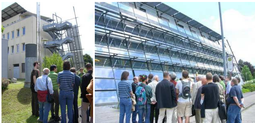
Links: Der kleine Turm mit Lufteinlass für den Erdreichkanal der Zuluft Rechts: Die teilweise mit Solargeneratoren verschattete Südseite der Solarfabrik. Fotos: G. Löser anl. einer Führung des Samstags-Forums Regio Freiburg von ECOtrnova e.V., 14.6.2008
