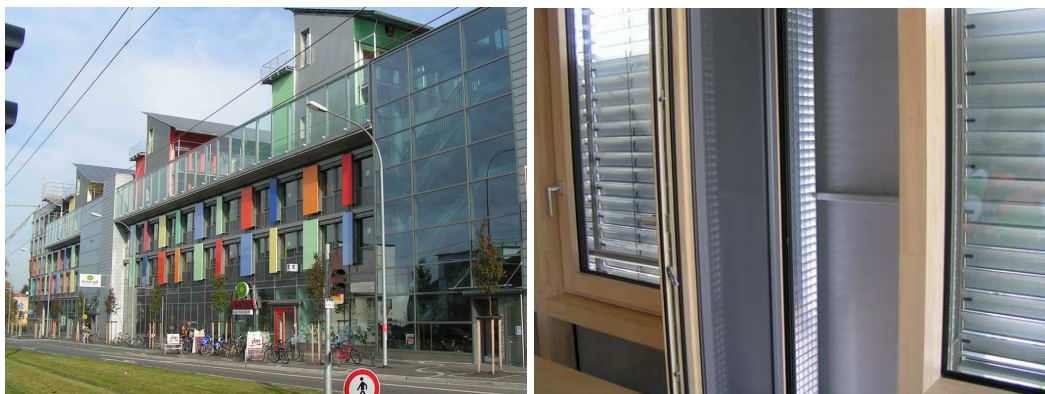
li.: Sonnenschiff der Solarsiedlung Freiburg re: geöffnetes Lüftungselement, Innenansicht. G. Löser, 2007, 2008
