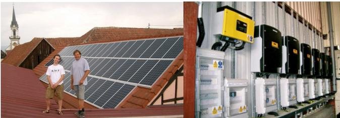
Auf dem Dach bei den Schnells Wechselrichter in der Scheune Eine **zweite Solarstromanlage** mit 45 kW<sub>p</sub> befindet sich auf einer Scheune in 200 m Entfernung vom Bauernhof. Sie besteht aus 500 m<sup>2</sup> Solargeneratoren des Fabrikats First Solar, und zwar mit Dünnschicht-Solarzellen, die einen Wirkungsgrad von etwa 10 % aufweisen. Die Wechselrichter sind auf dem Foto oben zu sehen..
