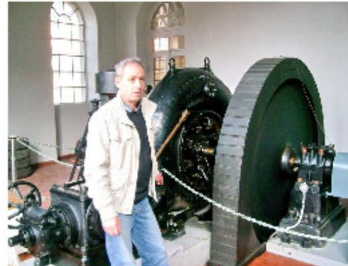
Das Wasserkleinkraftwerk in Mittlach im oberen Münster-Tal produziert Strom mit Wasser der Fecht am Zusammenfluß der Kolben-Fecht und des Langenwasen. Das Kraftwerk befindet sich in einer kleinen ehemaligen Textilfabrik und stammt aus dem Jahre 1927. Es hat eine Leistung von 75 Kilowatt und erzeugt jährlich rund 450 000 kWh. Das ist mehr als der Verbrauch eines Dorfes mit 320 Einwohnern wie Mittlach, das im Naturpark der Region liegt (Parc naturel régional des Ballons des Vosges).
