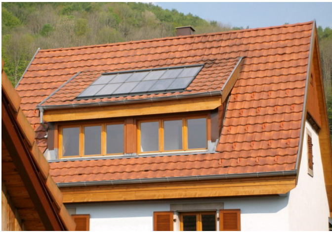
Sonnenkollektoren (oben), Solargeneratoren (unten)
