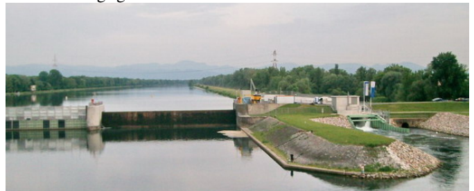
Das Kulturwehr des Altrhein bei Breisach, Kleinkraftwerk bei Breisach
