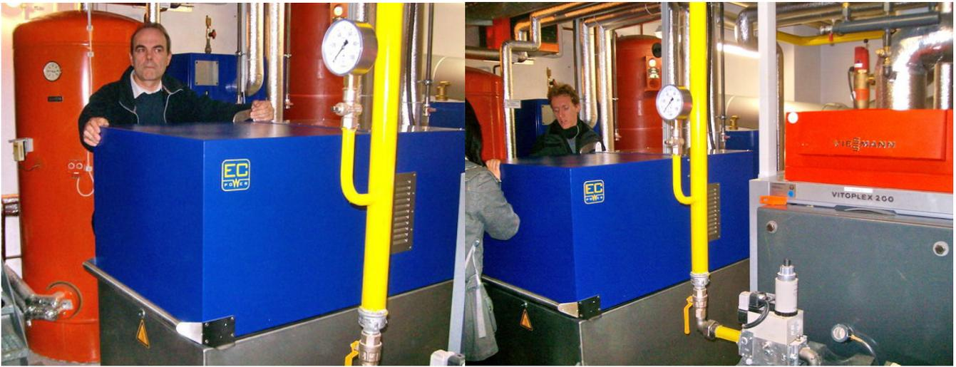
Horst Reisch und BHKW (blau, EC, 15 kWel, 30 kWth), dahinter: Heizung-Pufferspeicher 450 l, rot: Kl. Heizkessel 200 kW
