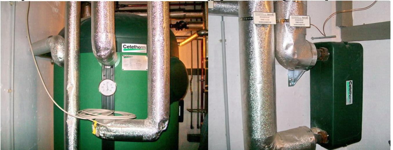
Pufferspeicher Wasserwasser (1000 l) und Wärmetauscher für Warmwasserspeicher-Beladung
