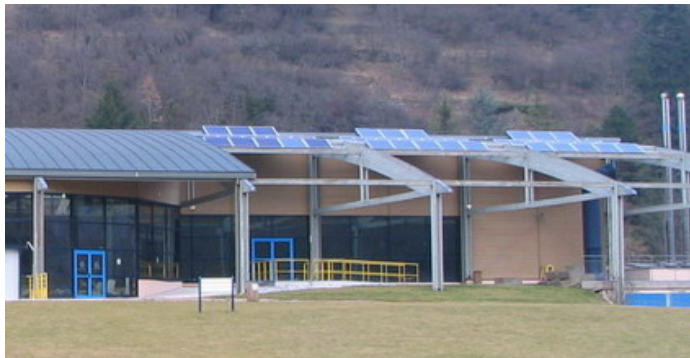
Schwimmzentrum Kaisersberg : mit Solargeneratoren auf dem Dach, rechts die Kamine der Heizungsanlage, Foto E. Schulz
