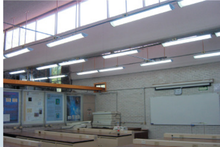
Laborraum mit neuer Beleuchtungsanlage mit Tageslichtregelung
