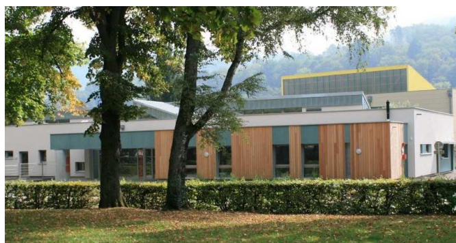
L'accueil périscolaire de Munster, à côté de la gare.
