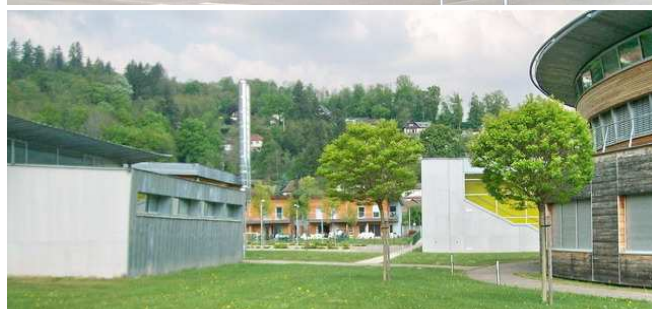
à gauche : le bâtiment de la chaufferie à plaquettes de bois du collège Frédéric Hartmann à Munster
