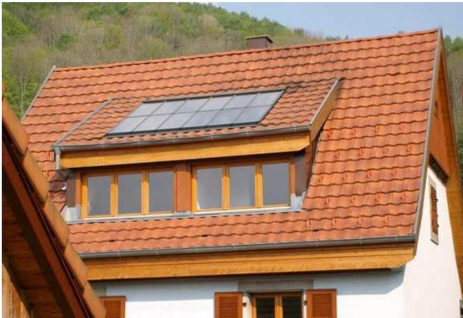
Capteurs solaires thermiques. Capteurs solaires photovoltaïques, au-dessous
