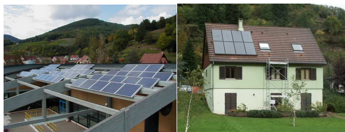
capteurs solaires photovoltaïques et (à droite) capteurs solaires thermiques, Espace nautique de Kaysersberg, rue du Geisbourg ; photos CCVK
