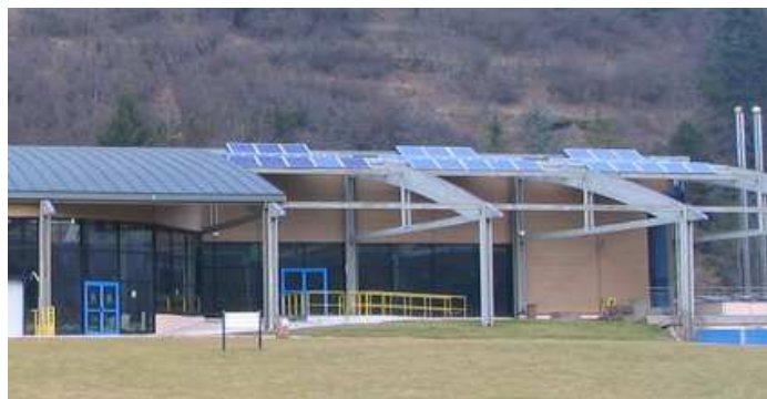
Espace nautique de Kaysersberg : capteurs solaires photovoltaïques ; à droite, les cheminées de la chaufferie ; photo E. Schulz
