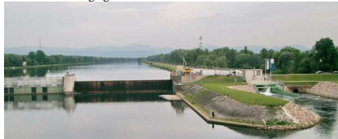
Le barrage du Vieux Rhin, la microcentrale à Breisach
