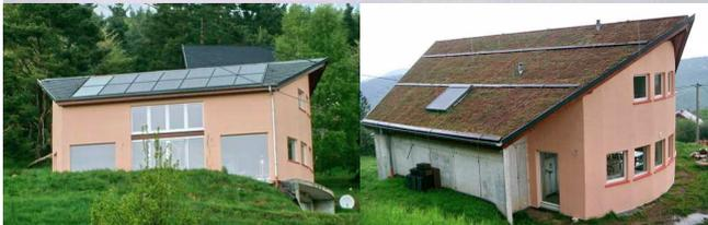
Cette maison aux granulés de bois et solaire passive et active à Labaroche (dans le Haut Rhin en Alsace) existe depuis fin 2007. La surface habitable est 148 m<sup>2</sup>. La construction est en ossature bois. La maison a une très basse consommation énergétique pour le chauffage des pièces : 20 kWh par m<sup>2</sup>.
