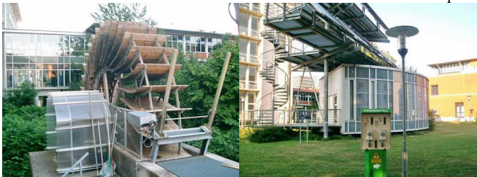
Roue hydr. Zuppinger. Tour solaire, station service solaire, une des lampes solaires
