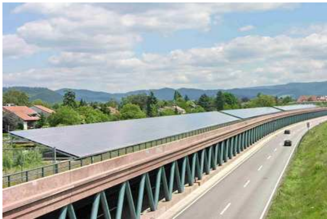
B 31 Est à Freiburg avec inst. PV de 366 kW, photo fesa-GmbH
