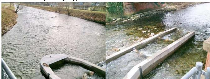
Nouvelle passe à poissons (2009) sur le piège à sédiment/barrage, au départ du Gewerbebach, photo de gauche. Photo de droite : extrémité inférieure de la passe
