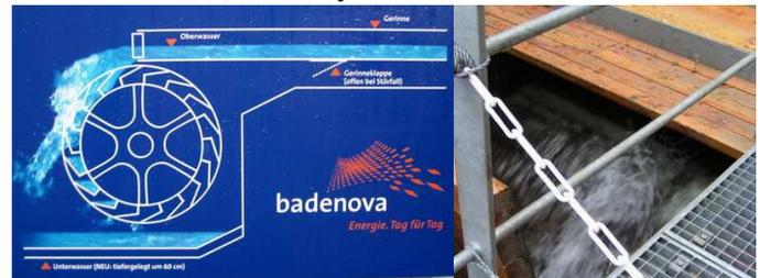
La roue à auge novatrice, prototype Hydrowatt de 5 m, très large, avec seulement 2 m de diamètre et 30 kW, permet de générer sur le Gewerbekanal env. 150 000 kWh/an depuis 2004, avec seulement 2,4 m de hauteur de chute, un débit de 2200 l/sec, et un régime relativement élevé de 16 tours/min. **Exploitant** : Michael Wagner, voir ci-dessus.
