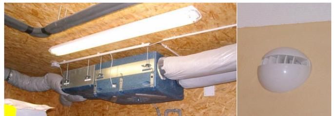
Wärmetauscher der Wärmerückgewinnung; Zuluftöffnung
