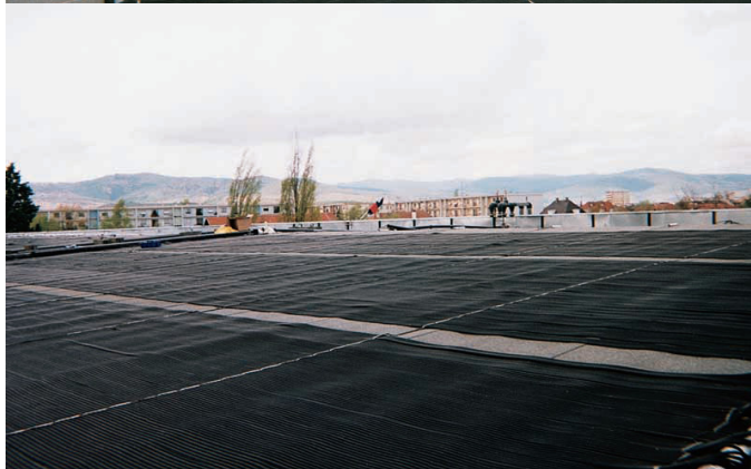
Solar-Absorbermatten auf den Dächern des Schwimmstadions Colmar
