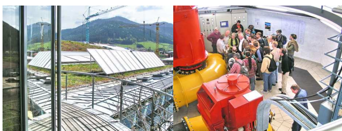
En haut : usine. La centrale hydr. est visible de l'extérieur dans le bâti rond circulaire du bas. En bas à g., instal. Solaire, à dr. visite de la centrale hydr.
