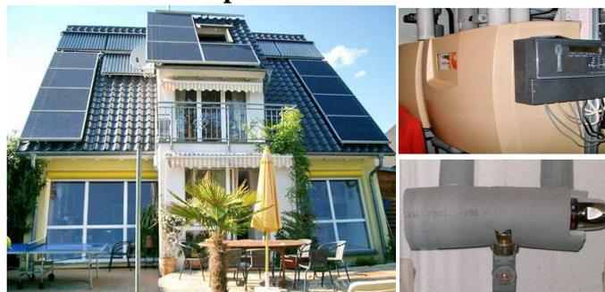
Côté jardin : utilisation passive du soleil via fenêtre, active via capteurs à tubes sous vide et panneaux PV; dr. : accumulateur solaire; mélangeur thermostatique pour alimenter le lave-linge en chaleur solaire, d'où économie d'électricité
