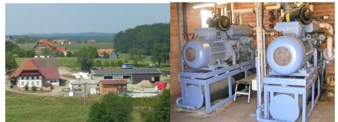
Unité de biogaz Reinbold : les cuves de fermentation sont enterrées. Moteurs de la centrale de cogénération dans le bâtiment rouge, au centre de la photo.
