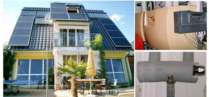
Gartenseite: passive Solarnutzung durch Fenster, aktive mit Vakuum-Röhrenkollektoren (Wärme) und Solargeneratoren (Strom); re.: Solarspeicher; Thermostatmischer für stromsparende Solarwärmezufuhr zur Waschmaschine
