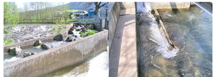
li.: Die rauhe Rampe des Wehr und Teil des Fischeufstiegs re: durch eine besondere Lockströmung werden Fische vom Rechen (Bildmitte) weg nach links in den Fischabstieg gelockt.
