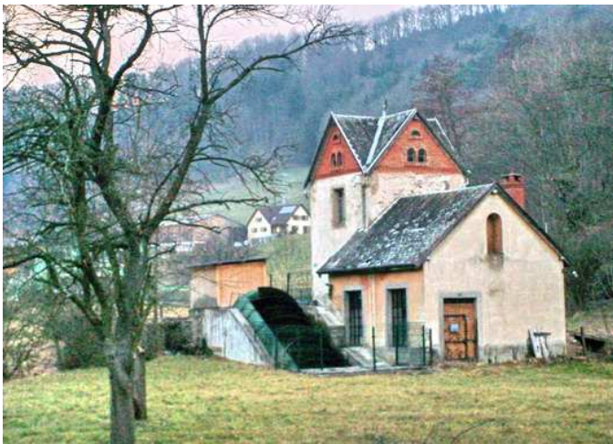
vue du pont de la Weiss : la vis hydraulique et le vieux bâtiment
