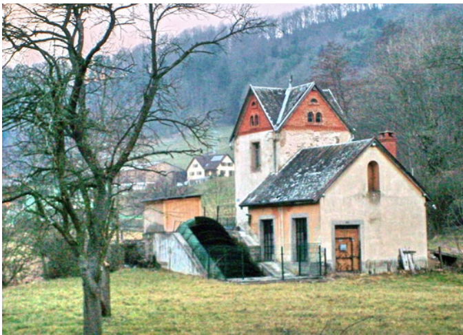
Blick von der Brücke über die Weiss zur Wasserkraftschnecke und zum alten Kraftwerksgebäude
