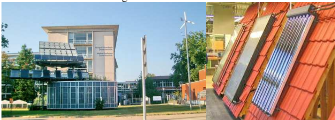
Solarturm und Kleinwindkraft
