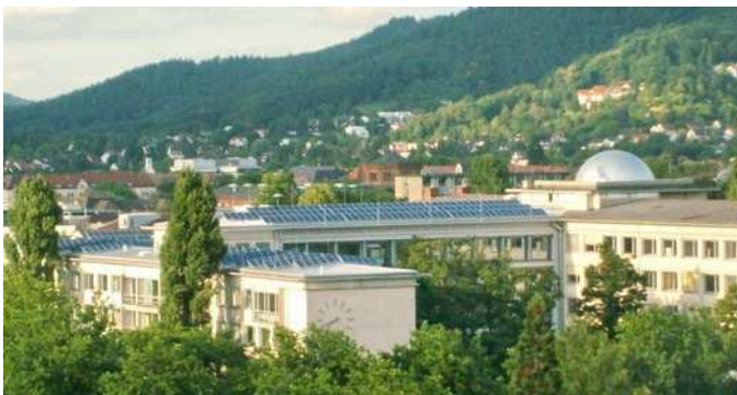
Richard-Fehrenbach-Schule (weitere PV-Anlage auf der Gerhard-Graf-Sporthalle)
