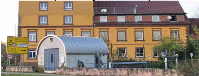
EM: centrale hydroélectrique EEE au moulin de Mundingen
