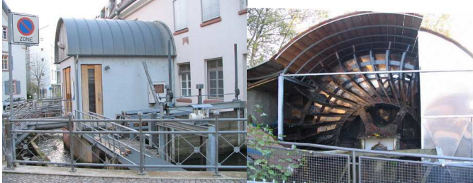
EM: Turbine EEE sur la porte de la ville (ga.), roue hyd. EEE, Romaneistraße
