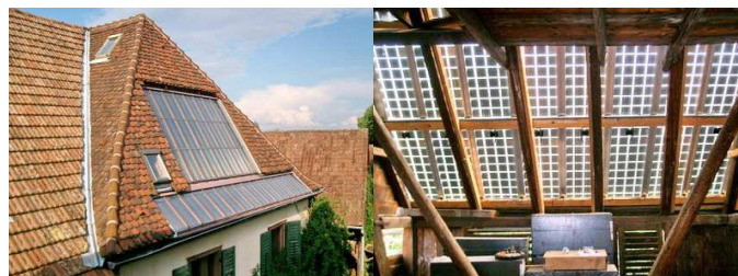
l'installation solaire thermique
