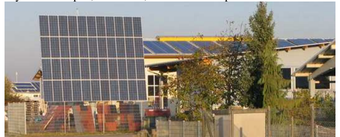
Entreprise « solaire » de charpente Schwörer, Wyhl, photo de 2008
