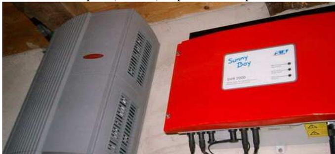
2 des 4 onduleurs (3 x Sunny Boy 2,5 kW, 1 x Fronius 4 kW)
