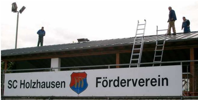
Das Dach ist begehbar, hier die Ostseite der Anlage
