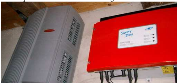
2 der 4 Wechselrichter (3 x Sunny Boy 2,5 kW, 1 x Fronius 4 kW)
