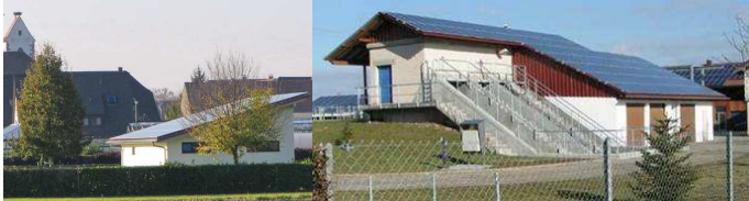
Abschiedshalle: 22 kW p , Erweiterung Kläranlage: 36 kW p
