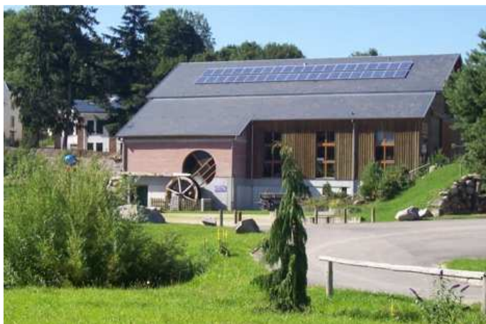
Musée du Bois à Labaroche, vallée de Kaysersberg. Centrale photovoltaïque de 80 m 2 ou 8 kW c , raccordé au réseau électrique en mai 2007
