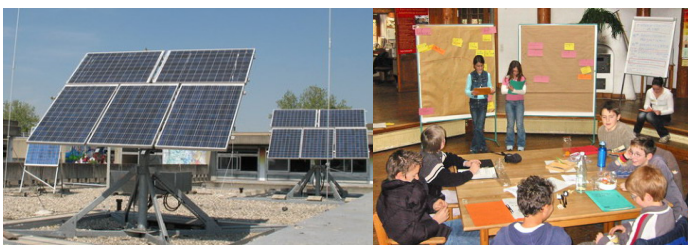
zweiachsig nachgeführte Anlage, Energiesprechertag in der Ökostation
