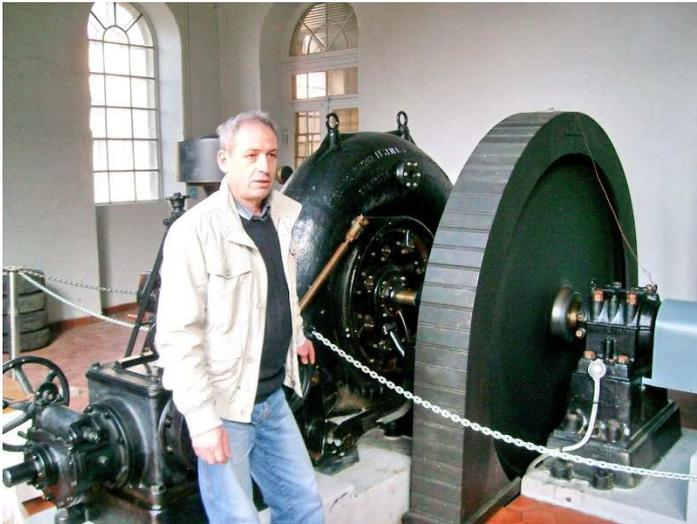
Das Wasserkleinkraftwerk in Mittlach im oberen Münster-Tal produziert Strom mit Wasser der Fecht am Zusammenfluß der Kolben-Fecht und des Langenwasen. Das Kraftwerk befindet sich in einer kleinen ehemaligen Textilfabrik und stammt aus dem Jahre 1927. Es hat eine Leistung von 75 Kilowatt und erzeugt jährlich rund 450 000 kWh. Das ist mehr als der Verbrauch eines Dorfes mit 320 Einwohnern wie Mittlach, das im Naturpark der Region liegt (Parc naturel régional des Ballons des Vosges).
