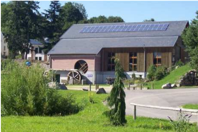
Das Holz-Museum in Labaroche: Solarstrom-Gemeinschaftsanlage mit 80 m oder 8,2 kW p , verbunden mit dem Stromnetz seit Mai 2007
