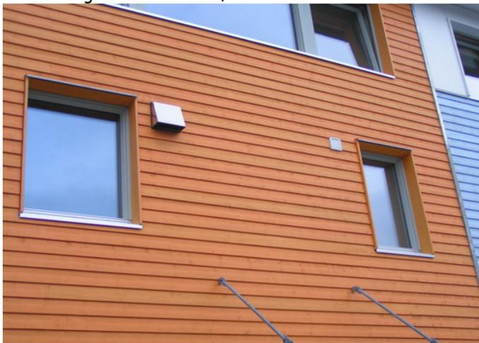
Lüftungsöffnungen für Wärmerückgewinnung und Bad-Abluft, 2007
