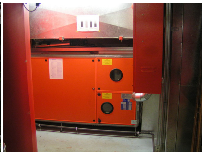
Passivhaus Wohnen+Arbeiten: Daten-Schild Nordseite Foto GL 12.5.07/Samstags-Forum; rechts: im Technik-Keller Lüftungsanlage mit Wärmerückgewinnung in der Technikzentrale (daneben, nicht auf Foto: das Klein-BHKW)
