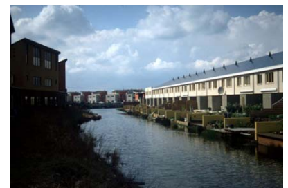
Bild 1: Ein Teil der dachintegrierten 1 MW-Fotovoltaik-Anlage in Amersfoort Niewland, hier auf Reihenhäusern
