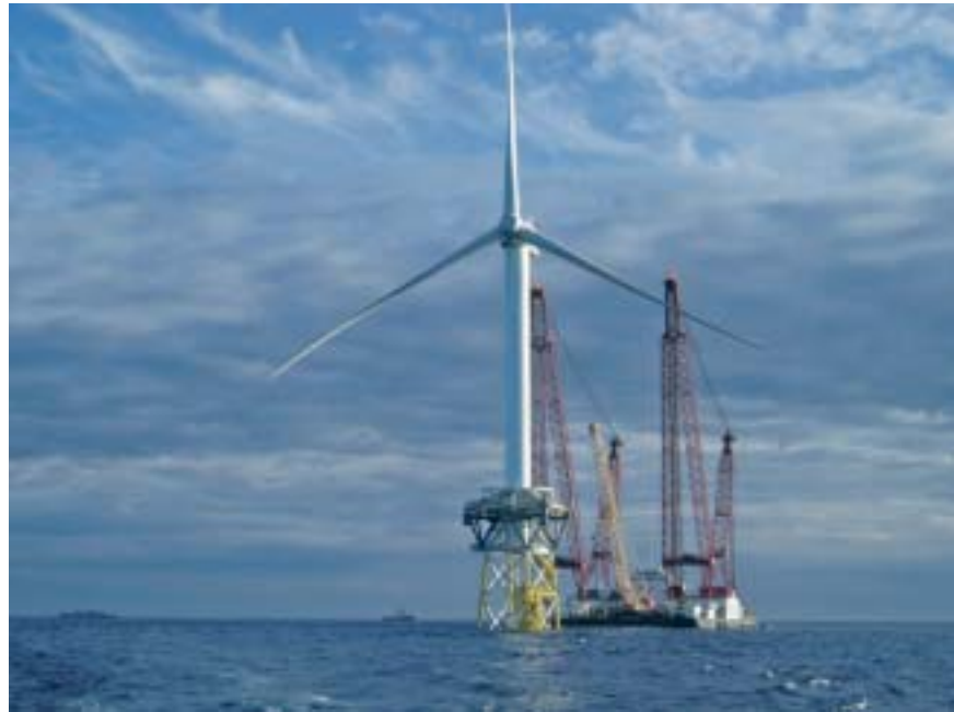
Abb. 10: Installation einer 5-MW-Offshore-Windenergieanlage mit 126 Metern Rotordurchmesser vor der schottischen Küste im August 2006 [REpower Systems AG].
