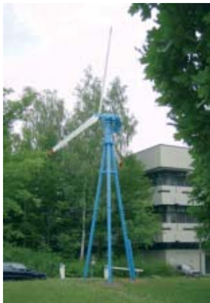
Abb. 5: Restaurierte Windenergieanlage WE-10 (Ø 11,28 m, 7,2 kW, 1952) auf dem Stuttgarter Campus.
