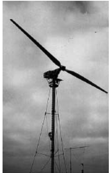
Abb. 6: Urmotiv vieler moderner Windenergieanlagen: Die von U. Hütter 1957 entwickelte Anlage StGW 34 (Ø 34 m, 100 kW).
