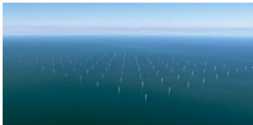
Abb. 9: Offshore-Windpark Horns Rev, Dänemark, mit 80 Zwei-Megawatt-Anlagen [Elsam].
