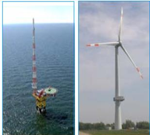
Vermessung des Prototypen Multibrid M5000, 5MW, Ø116m
