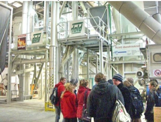
Teil der Pelletieranlage
