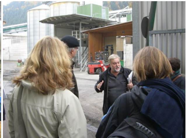
im Hintergrund zwei Pellet-Silos
