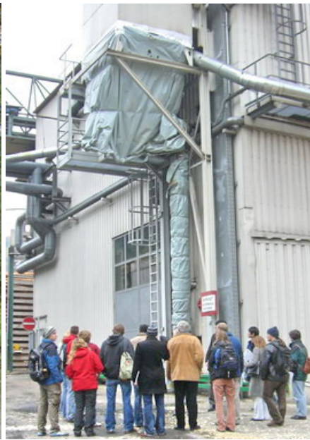
außen am Heizkraftwerk
