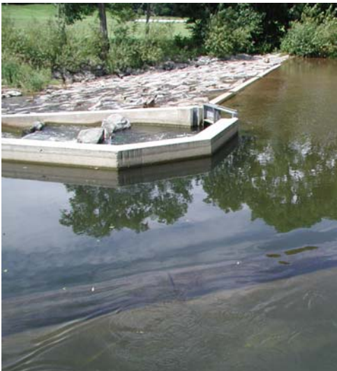
Abb. 5.2: Neuer Steinschüttdamm mit Beckenpass und Postivschwelle
