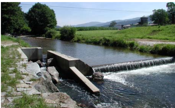
Abb. 6.2: Pegel Bleibach (Strecke C) mit Raugerinne-Beckenpass.
