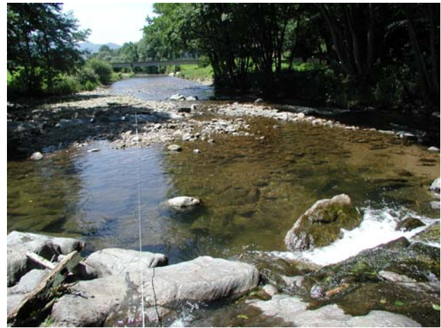
Abb. 6.6: Sturzbett Wehr Heitzmannhof mit Kiesinsel, rechts Fischpass. Blick fluab.
