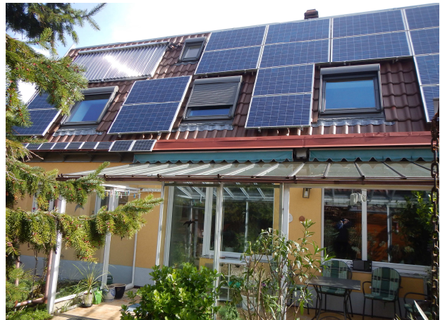
Solar-/ Energiesparhaus M. Konstanzer, 30.4.2016 Foto Löser
