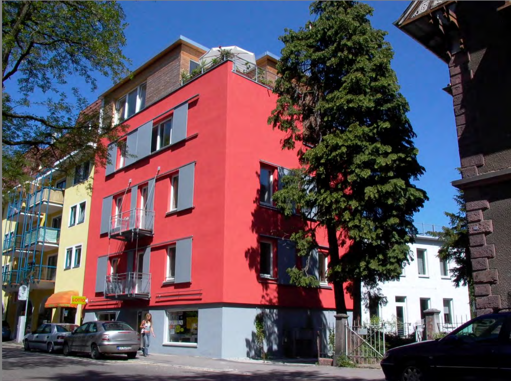
Aufstocken und Dachausbau für mehr Wohnraum
