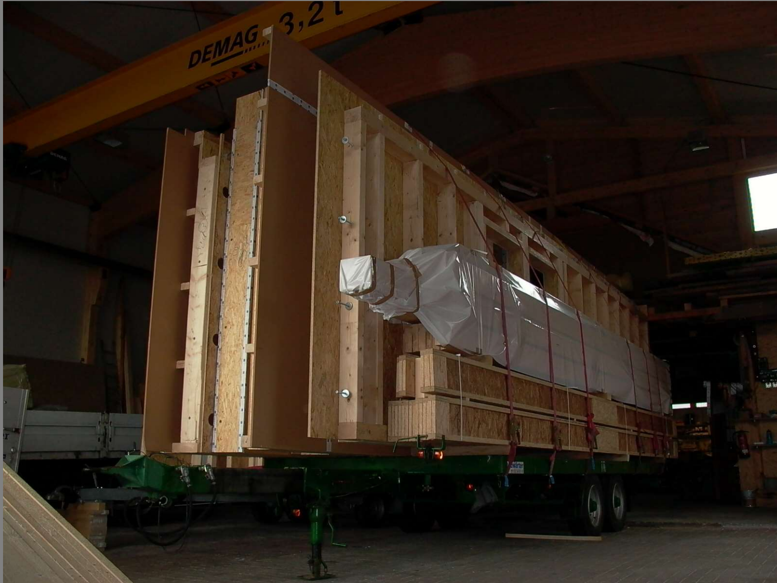
Aufstocken und Dachausbau für mehr Wohnraum
