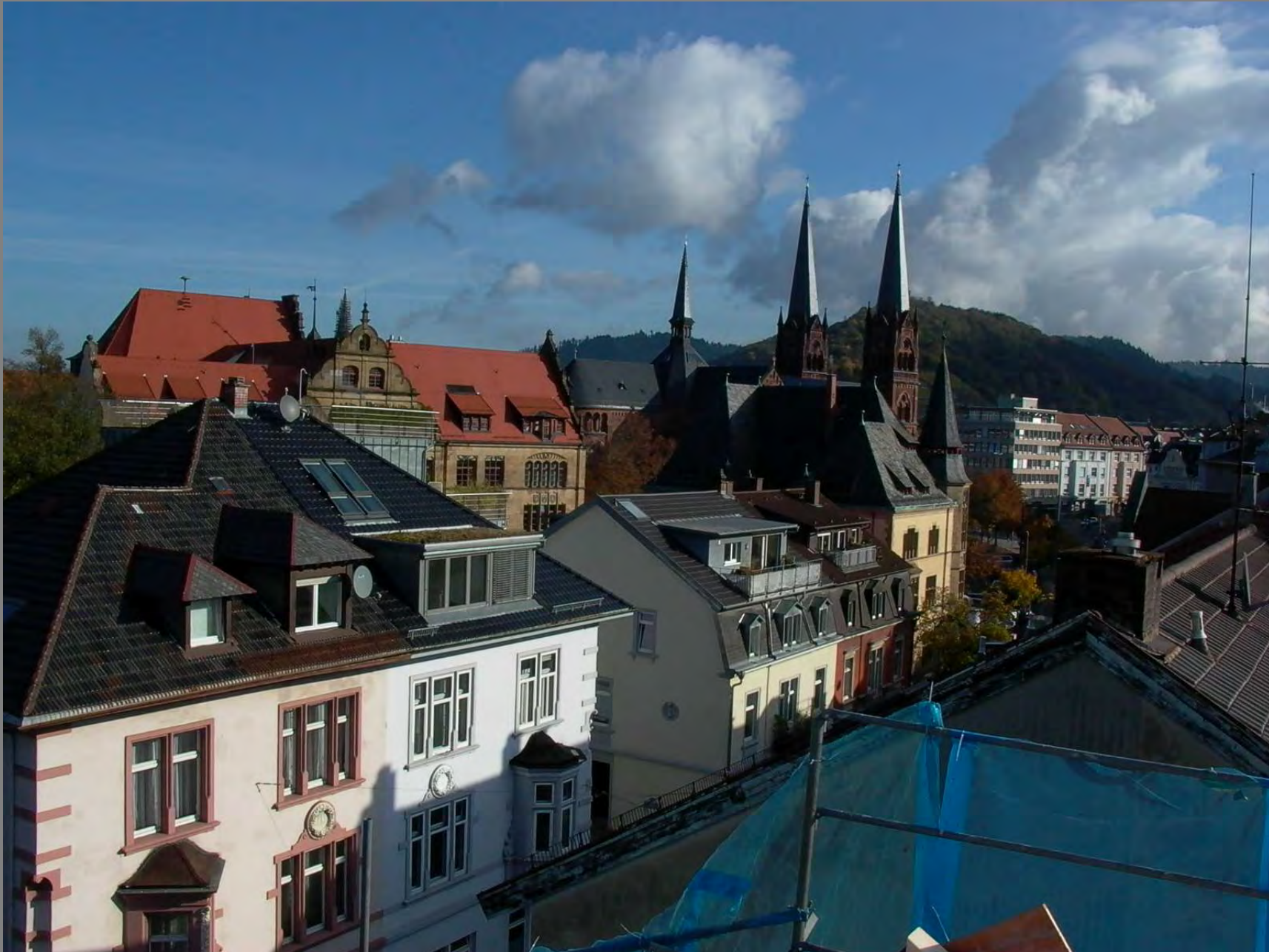
Aufstocken und Dachausbau für mehr Wohnraum
