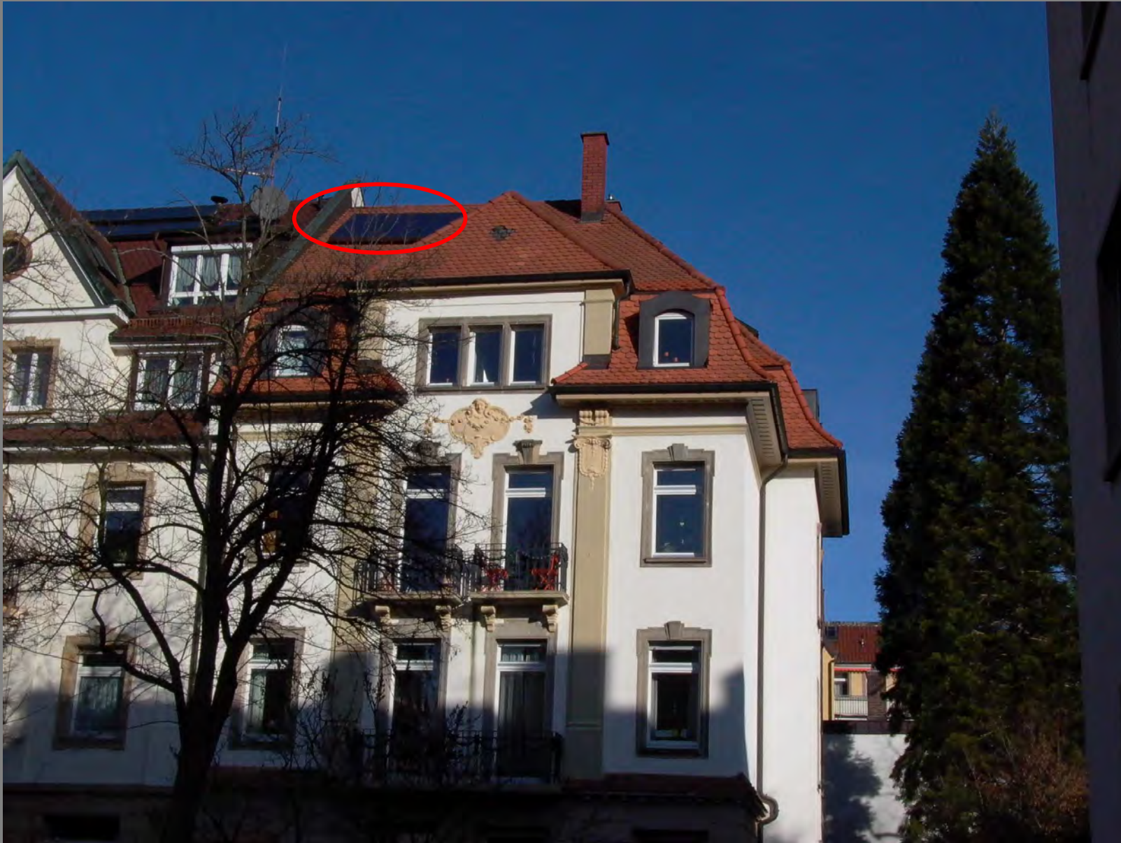
Aufstocken und Dachausbau für mehr Wohnraum
