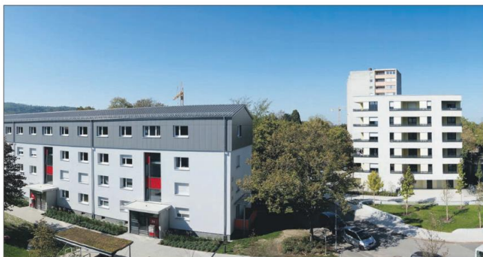
Blick in die Belchenstraße: Auf der linken Seite der modernisierte Gebäuderiegel mit gut erkennbarer Aufstockung. Auf der rechten Seite sieht man das neue Punkthaus der Belchenstraße 10 und direkt dahinter das zum Abriss bestimmte Hochhaus Belchenstraße 8. (Foto: A. J. Schmidt)
