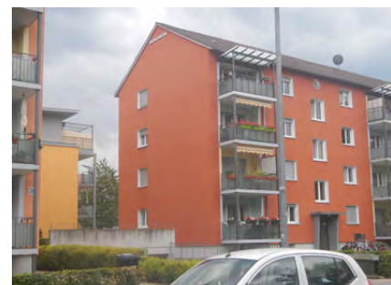
Fehrenbachallee, Dach ausbaubar.
