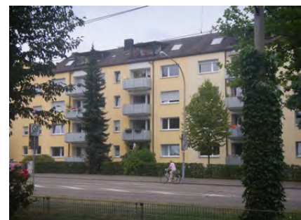
Fehrenbachallee, Dach bereits ausgebaut.
